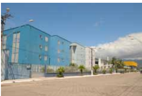
Blocos dos apartamentos
