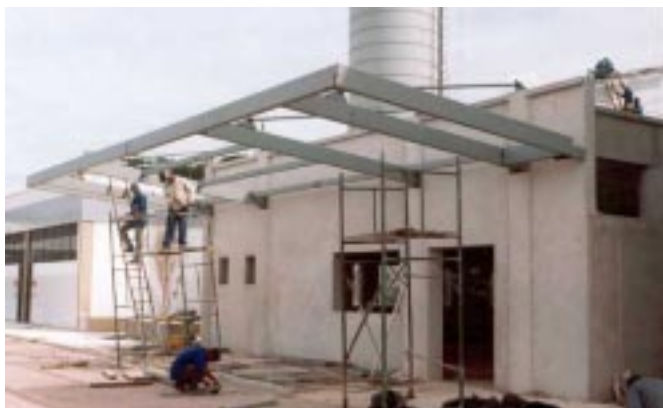
Estrutura da cobertura da entrada da administração
